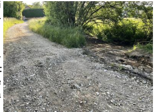
Une des buttes créés dans le chemin forestier des Combattes pour freiner l'eau et la rediriger vers un fossé
